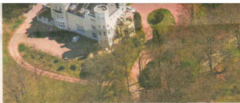
Die Villa mit Anbau an der Golfstraße 1 wurde bereits als Seniorenresidenz genutzt. Foto: 802/802
